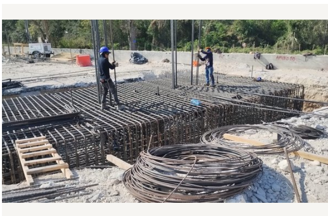
Habilitado de acero de refuerzo.
