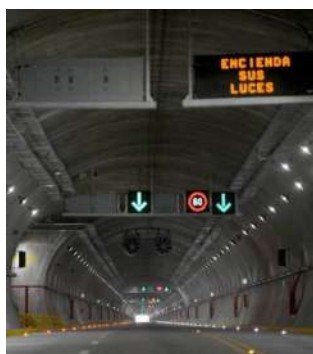
Acatúnel · Entronque Brisamar
