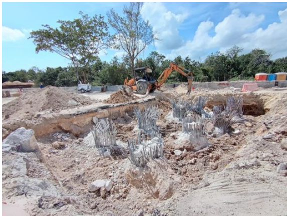
Movimiento de tierras en el frente de obra.
