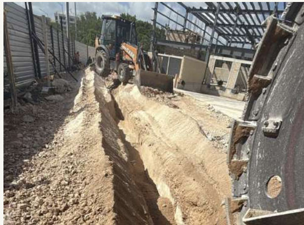
02 • Terracerías y zanjado de alta capacidad
