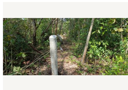
Poste para delimitación del DDV.
